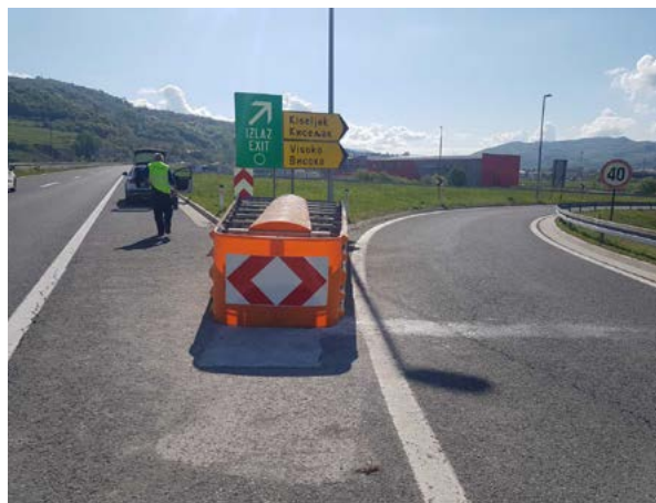
Primjeri postavljenih ublaživača udara i završetaka sigurnosnih ograda sa efektom ublažavanja.
