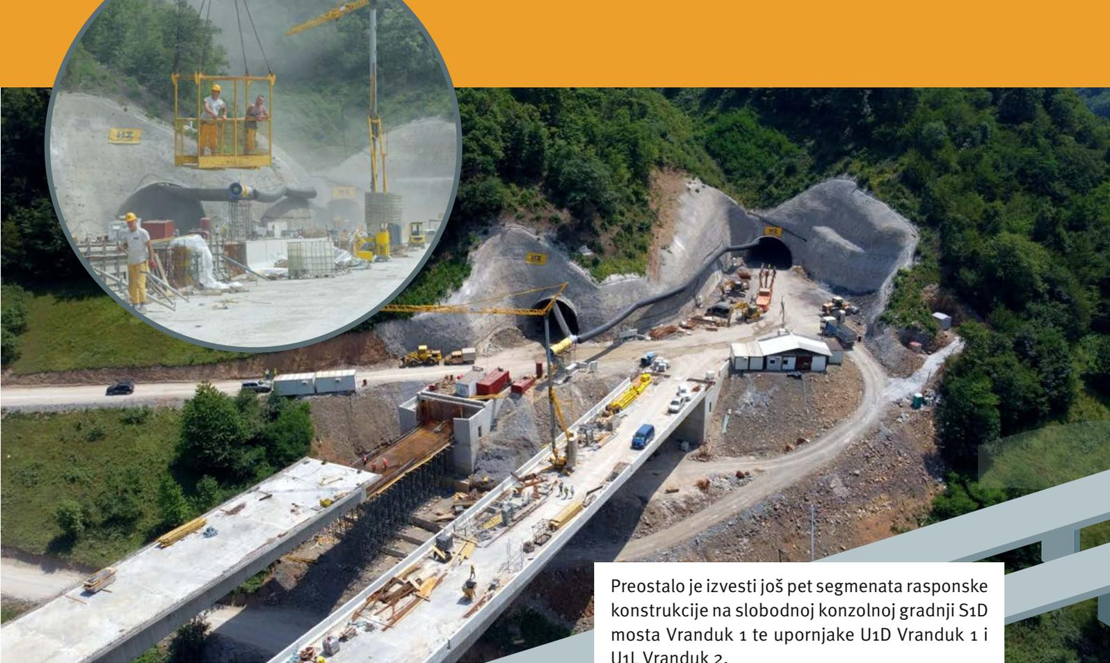
Preostalo je izvesti još pet segmenata rasponske konstrukcije na slobodnoj konzolnoj gradnji S1D mosta Vranduk 1 te upornjake U1D Vranduk 1 i U1L Vranduk 2.
